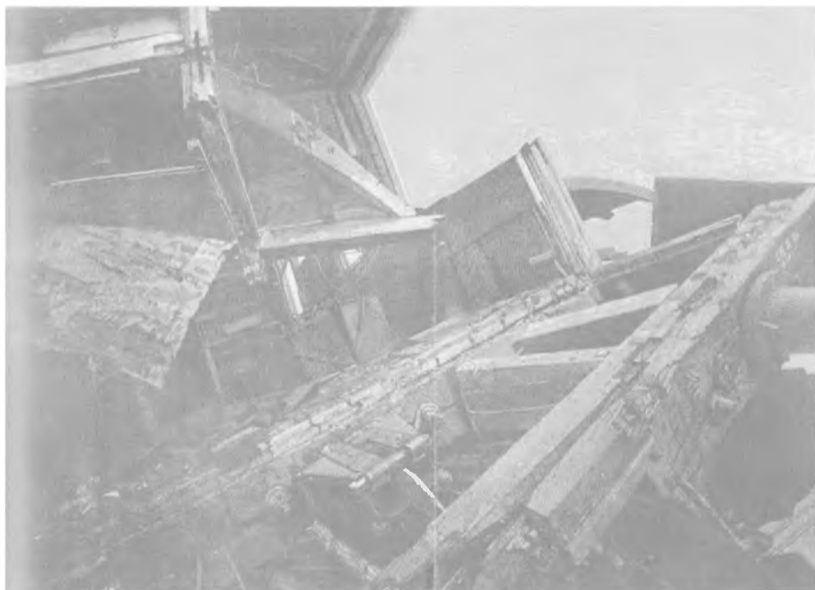
10 Железнодорожная катастрофа под Борками. Разрушенная ходовая тележка вагона-головной. Иллюстрации из журнала Нива от 12 ноября 1888 года
